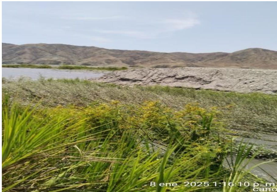
FIGURA N°02: SE APRECIA QUE LA DEFENSA EXISTENTE EN LA MARGEN IZQUIERDA DEL RIO SANTA SE ENCUENTRA DAÑADA, EROSIONADA, CON TENDENCIA A SER DESLIZADO POR EL AUMENTO DEL VOLUMEN Y AFECTAR AREAS AGRICOLAS E INFRAESTRUCTURAS HIDRAULICAS ALEDAÑAS A ESTA.
