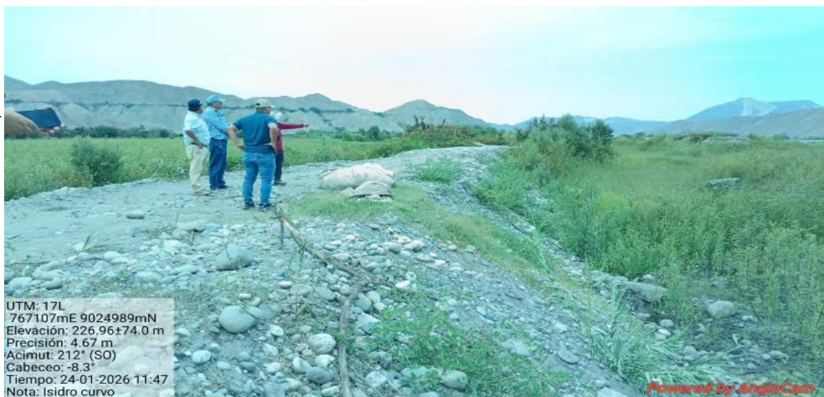
FIGURA N°03: TRAMO DEL RIO DE 80 ml QUE NO TIENE PROTECCION EN LA MARGEN IZQUIERDA DEL RIO, POR TANTO PUEDE AFECTAR A AREAS AGRICOLAS, POBLACION E INFRAESTRUCTURAS HIDRAULICAS ALEDAÑAS A ESTA.
